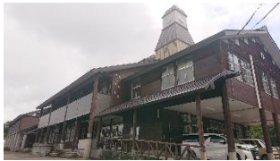
外壁補修、塗装、ベランダ 工事も終わり、校舎改築の 足場が撤去されました。
